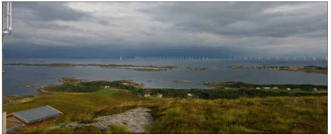
UROLIG FARVANN: Den tiltenkte vindparken Havsul 1, her sett fra Harøya, er i hardt vær. Regjeringen har det siste året vedtatt krevende støtteordninger for havvindprosjekter i norske farvann. Nå er siste håp for Vestavind Offshore at de får inngå som en del av strømforsyningen til et olje- og gassanlegg. Det vil gi de mulighet til å komme inn under det svært gunstige petroleumsskatte-regimet.
